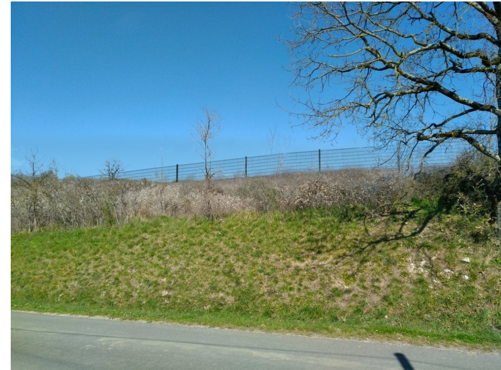
Figure 15 : Vue projetée sur la centrale solaire depuis la route communale au sud © 3D vision
